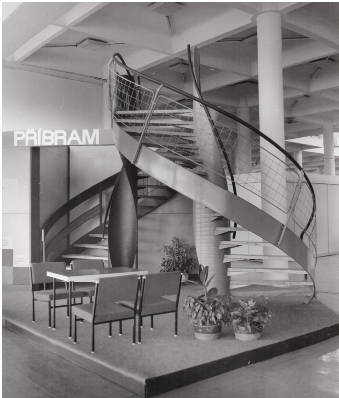
Obrázek 3, Točité schodiště 1986 na BVV, patent Václava Šlapáka z roku 1972 (archiv autorky)
