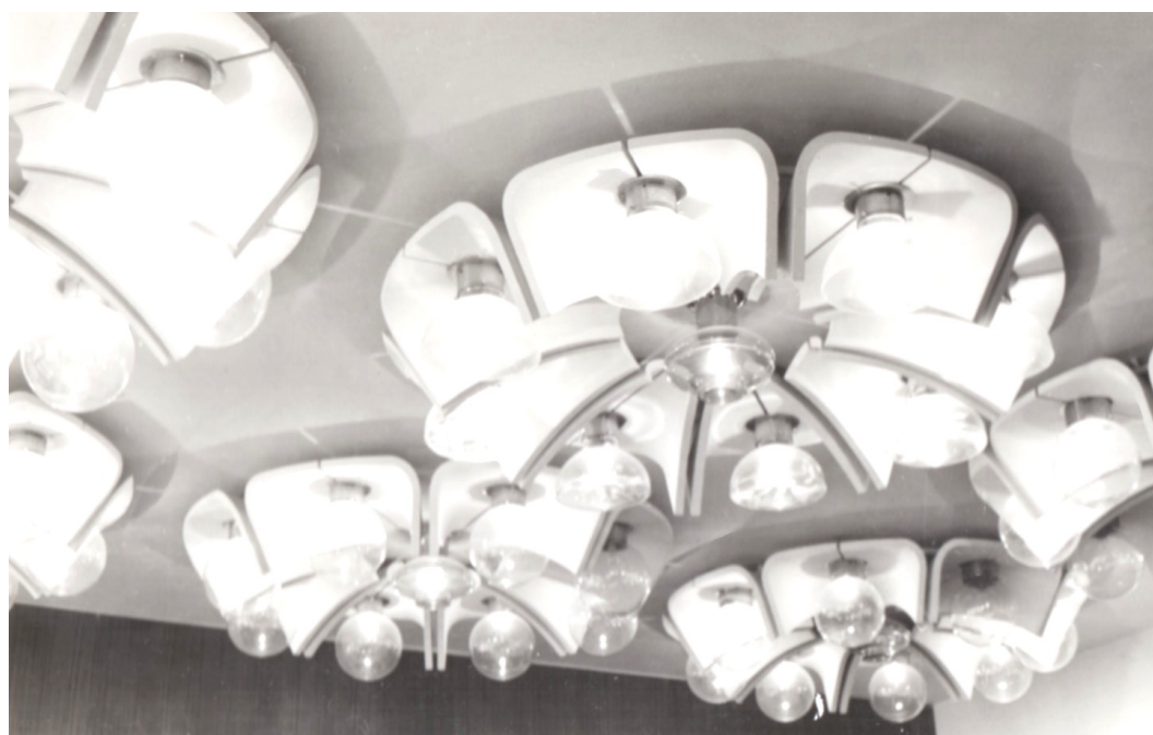
Obrázek 268, Hotel Flóra Olomouc 1982, ohýbaný polystyren využitý na stropu baru. (archiv autorky)
