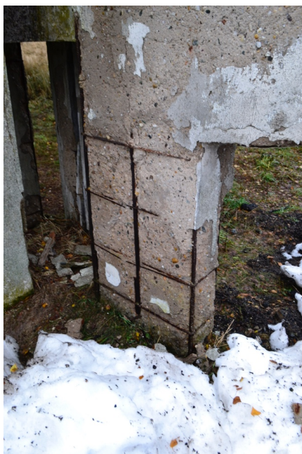
Obrázek 10, Degradace materiálu ve spodní části plastiky před společností Preciosa v Kamenickém Šenově v prosinci 2018. (archiv autorky)
