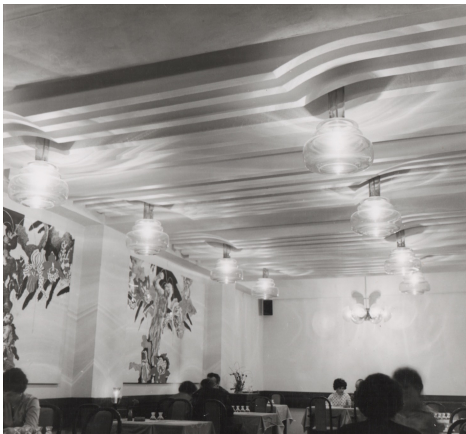
Obrázek 291, Hotel Flóra Olomouc 1982, ohýbaný polystyren využitý v jídelně hotelu. (archiv autorky)
